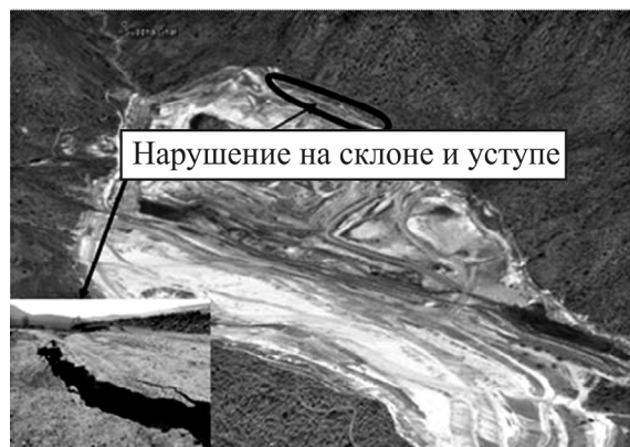
Рис. 1. Обрушение борта разреза с развитием оползня
