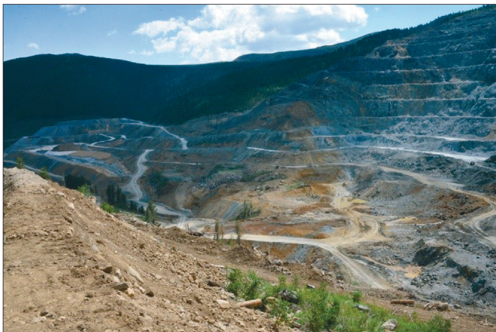
Рис. 1. Общий вид эксплуатационного карьера месторождения Кызыл-Таштыг.
